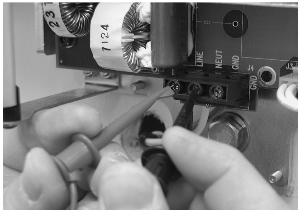
Figure 31 Vérification de la tension d'entrée au niveau de l'entrée de ligne
